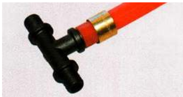
4. Насаджування труби з латунним кільцем на фасонні вироби
