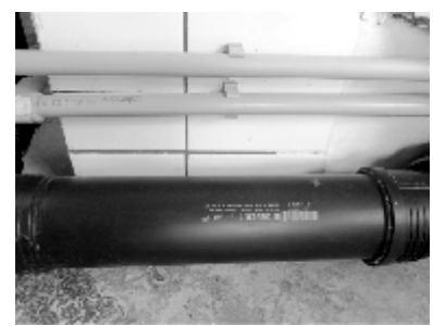
Рис.64. Труби і фітинги для шумопоглинаючої каналізації
